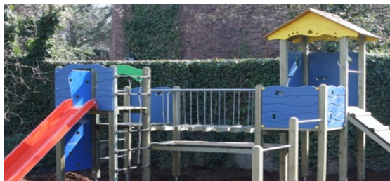
Das beliebte Klettergerüst wurde 2009 in Betrieb
